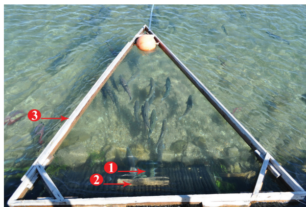
Рис. 7. Открытое «окно» в РУЗ и проходящая в него нерка (1 — отверстие в РУЗ; 2 — запирающий щит; 3 — «телевизор»)
